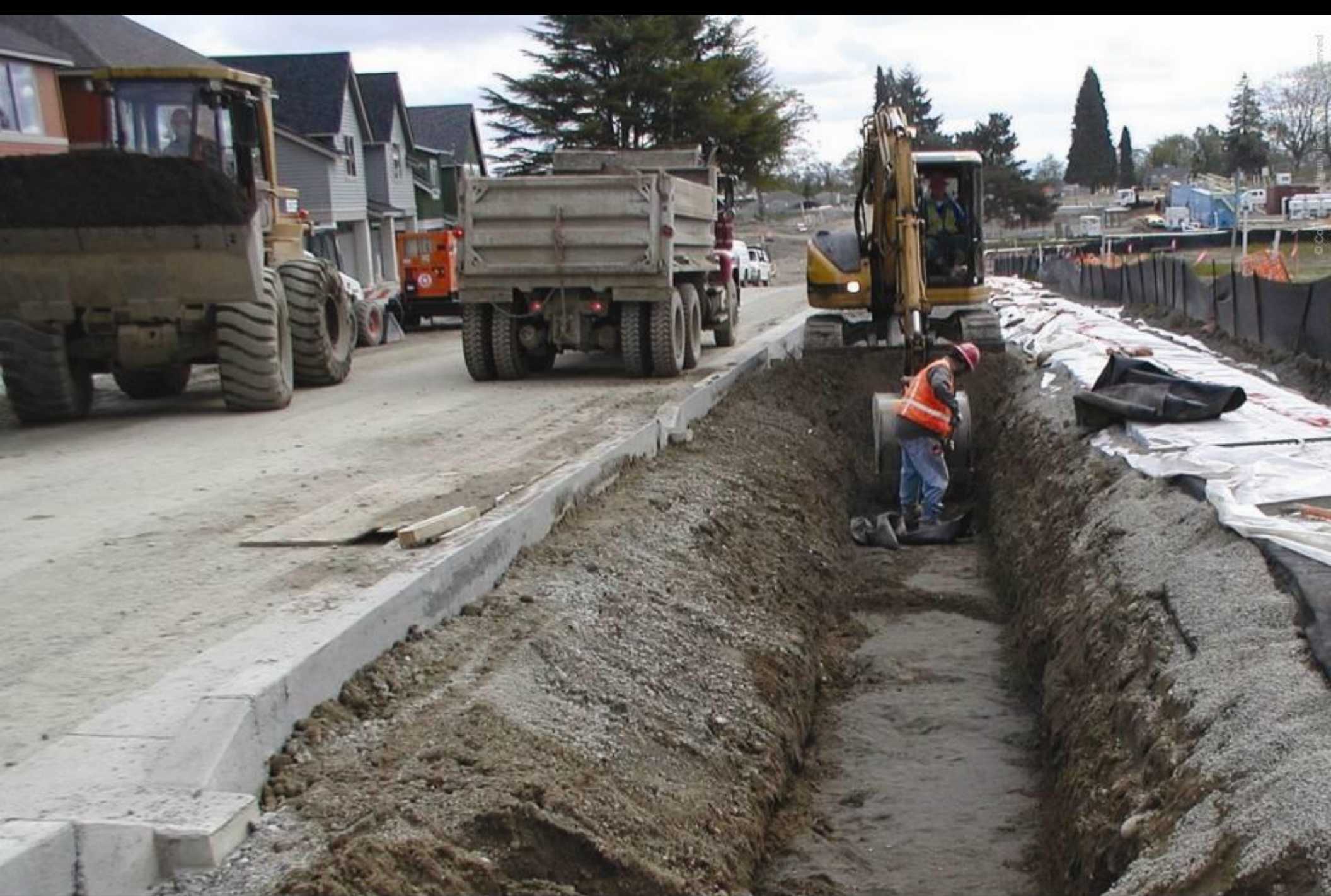
Bioswale Construction
